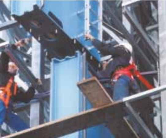
Transport und Einbau von Regalbedienelementen für das Unternehmen Wella
