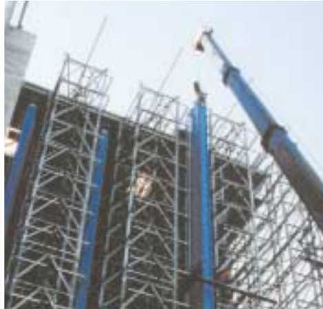
Transport und Einbau von Regalbedienelementen für das Unternehmen Wella
