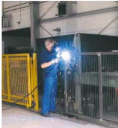
Neuanfertigung: Ändern von Schutzeinrichtungen nach einem Maschinenumzug
