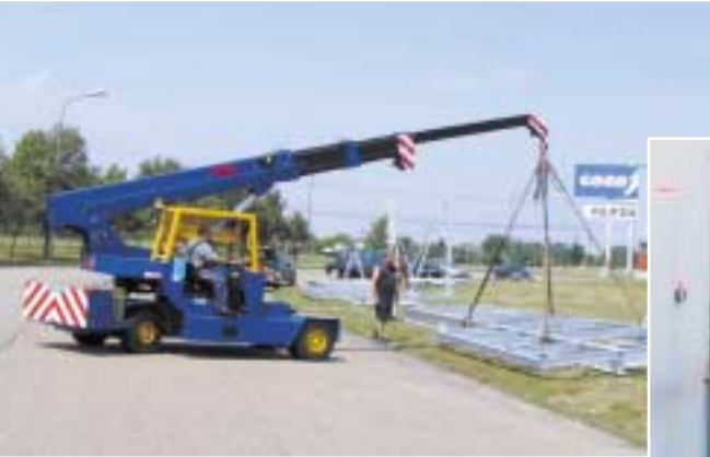
Wir fertigen Stahlkonstruktionen und montieren diese vor Ort
